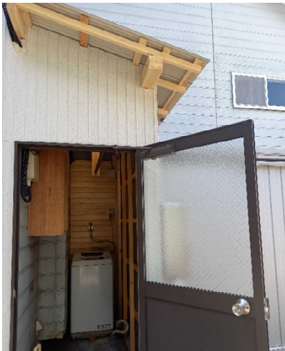
洗濯機用の小さな小屋ができました。
