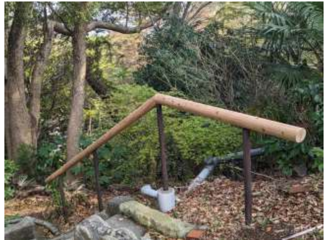
中学校中庭から家庭科室に行く階段に手すりが つきました。
